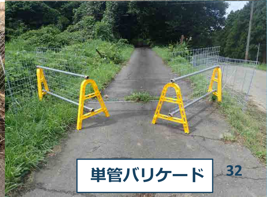
大型車両用ゲート（約7m） 単管パイプ、ターンバックルなど
