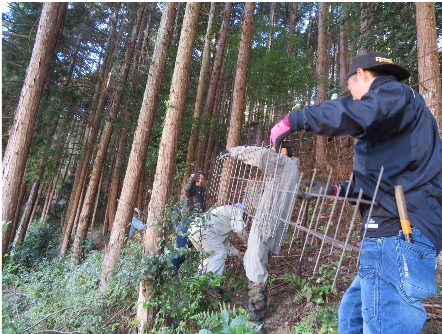
年間計画で柵の補修・補強(平成30年11月4日)
