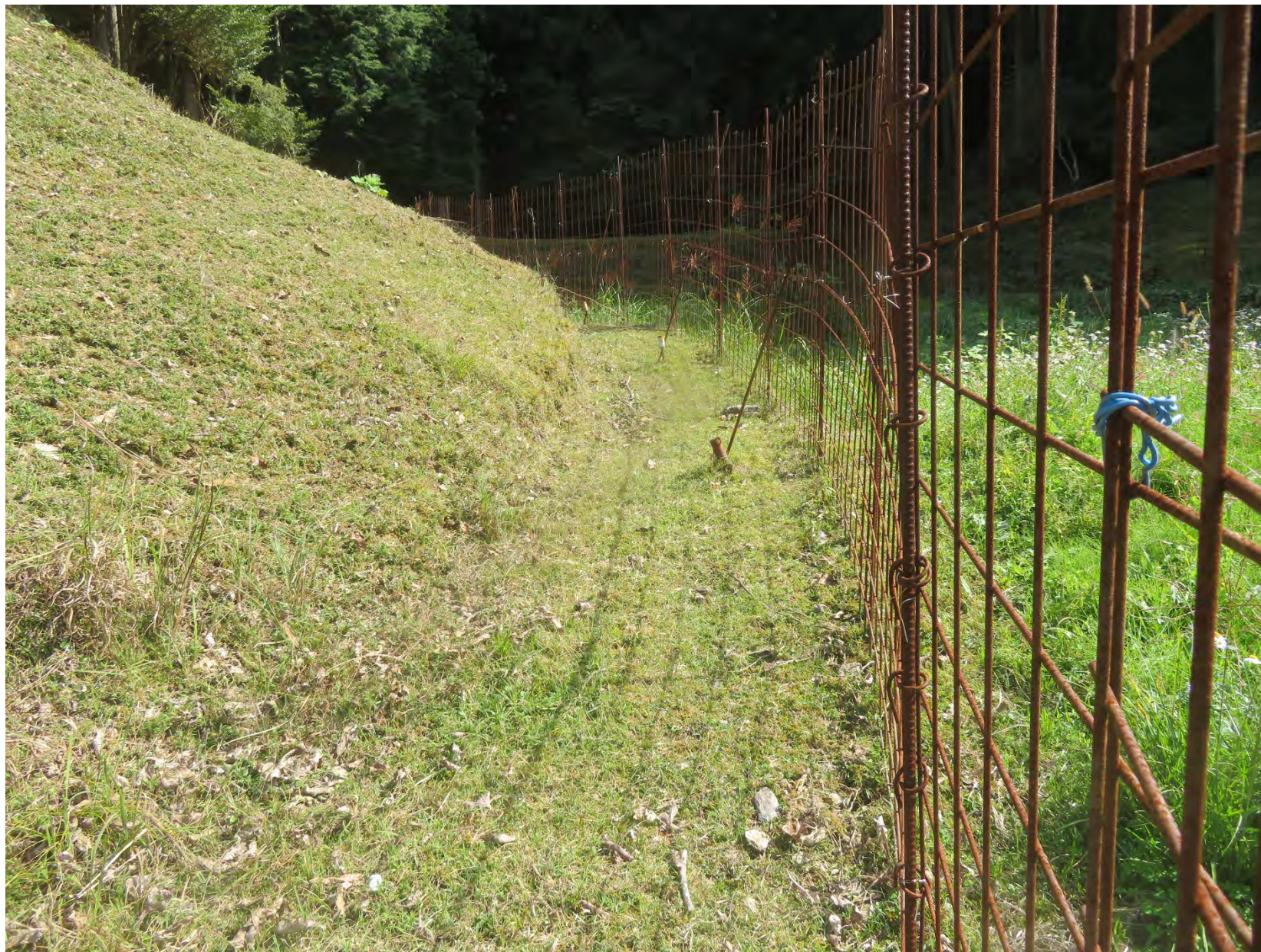
地域施工でWM柵(鉄柵)を設置
