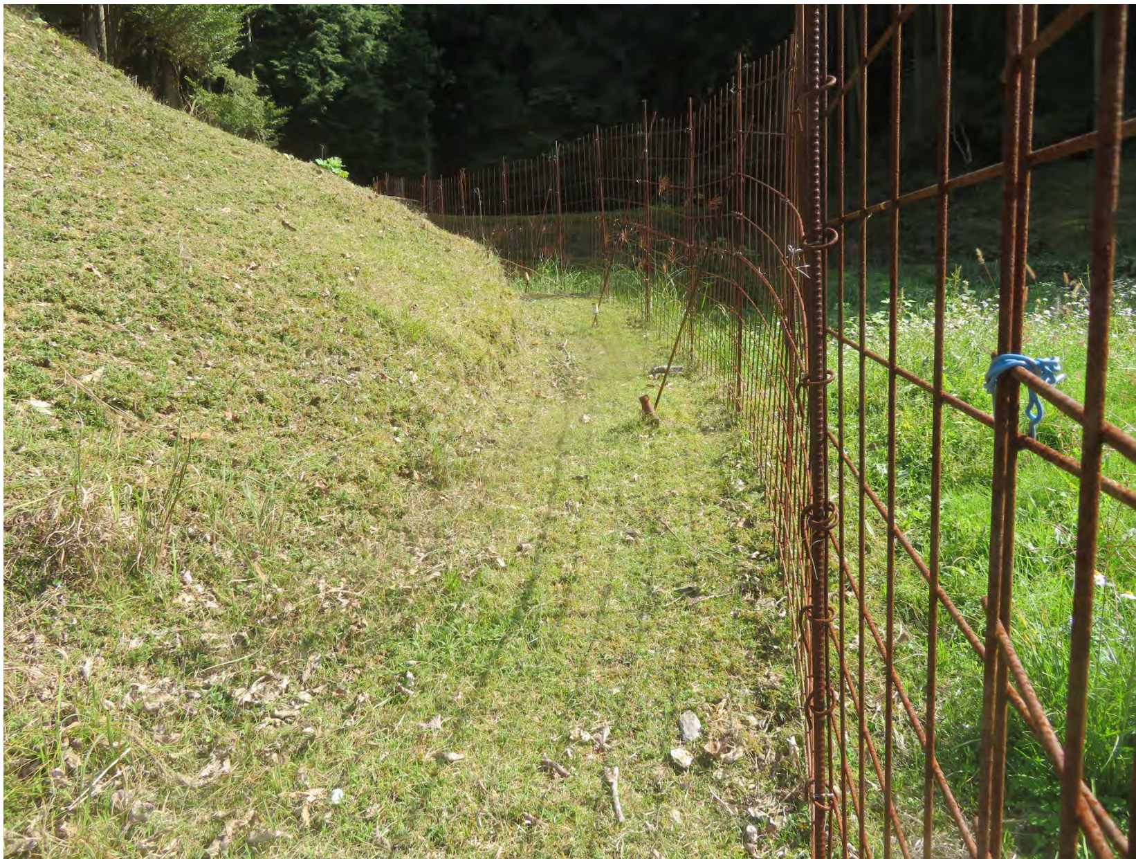
地域施工でWM柵(鉄柵)を設置
