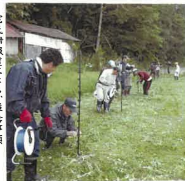
写真説明：電気柵設置作業（上稲荷地内）
