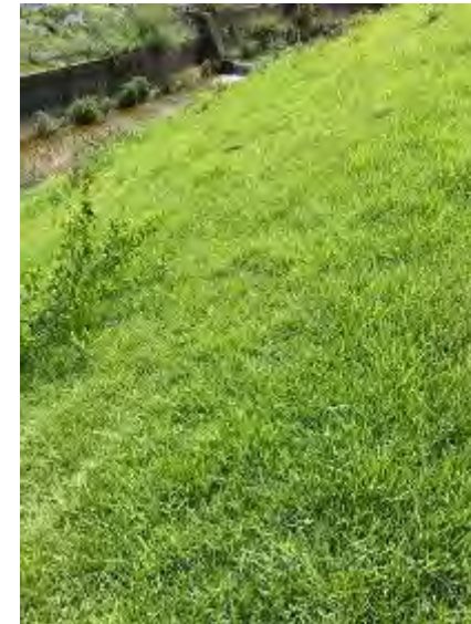
写真 ノシバ被覆後の様子(令和4年6月)
