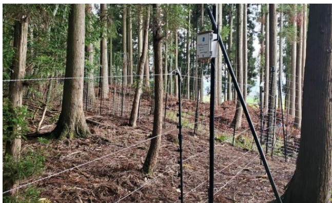
電気柵電圧監視システム
