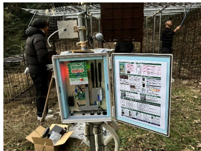
遠隔監視・自動操作システム
