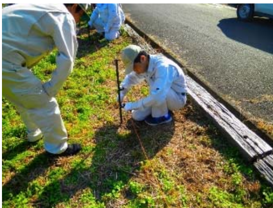
電気柵の設置実習の様子
