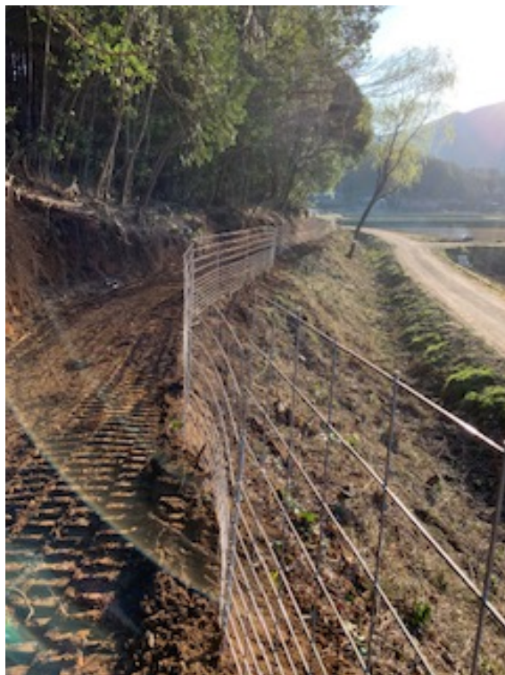
図 5. 設置が完了したイノシシの防護柵
