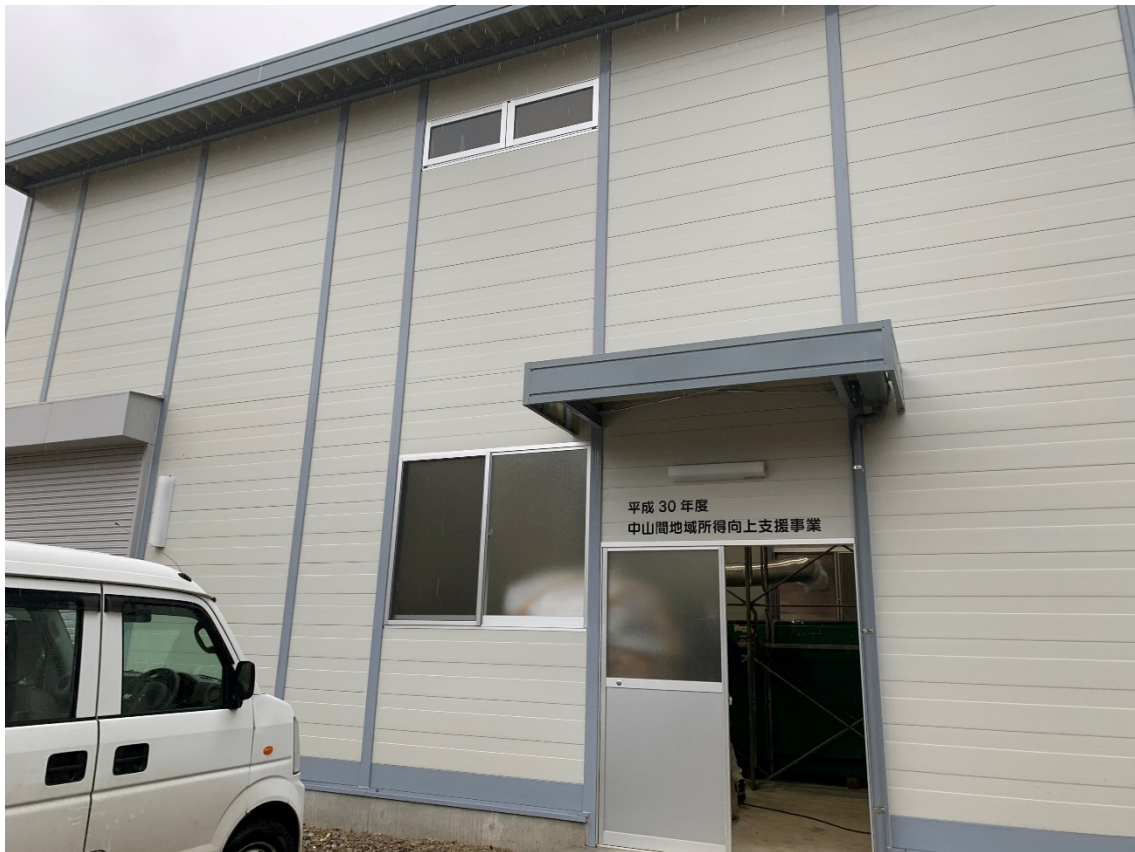
図 2. 宮城県村田町減容化処理施設の外観
