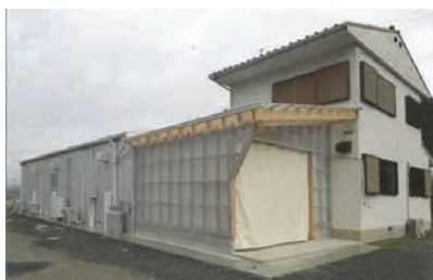
＜中核処理施設「京丹波自然工房」＞
