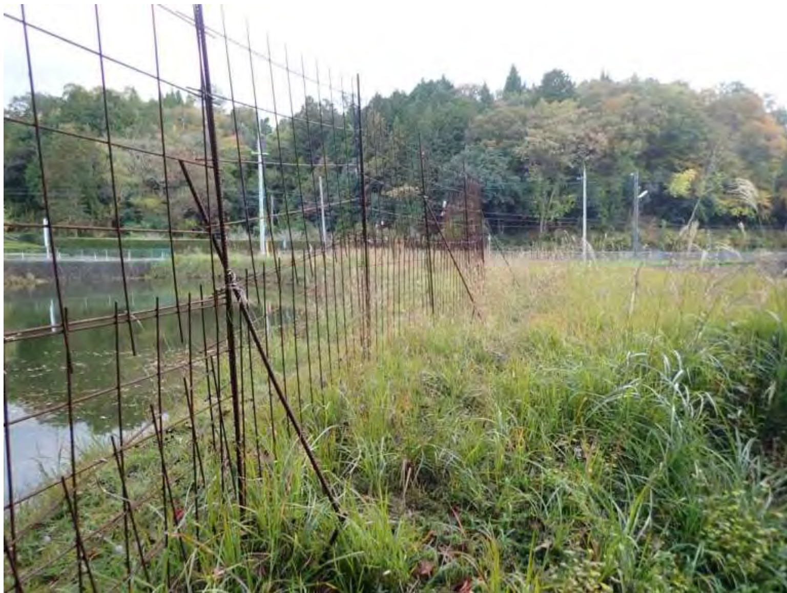
地域施WM柵(鉄柵)を設置
