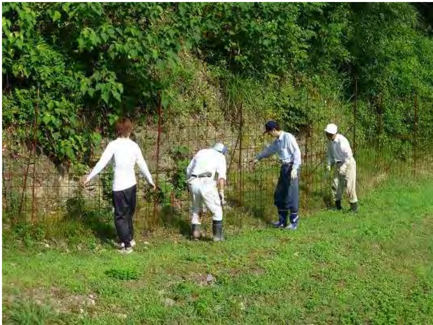
設置したWM柵は地域で点検
