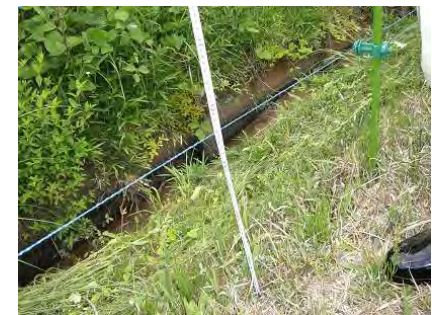
間違った電柵設置
