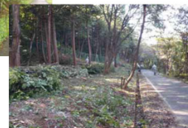
緩衝帯の設置
