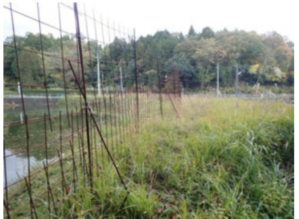
地域施WM柵(鉄柵)を設置
