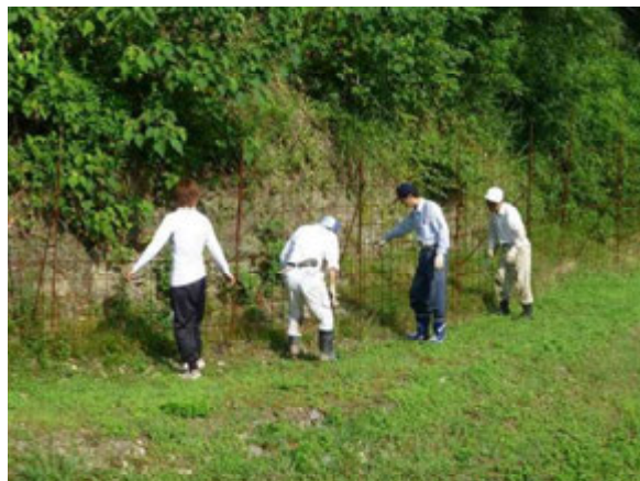
設置したWM柵は地域で点検
