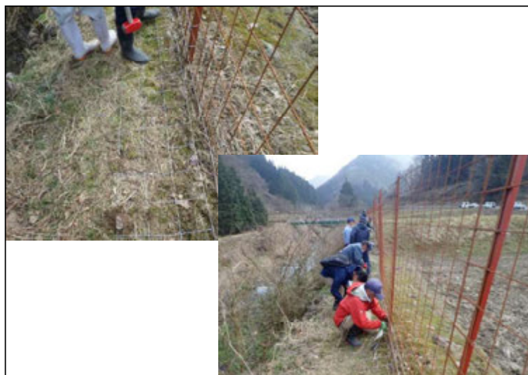
本プロジェクトで裾部分の改良
