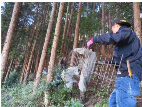
設置したWM柵は地域で補修
