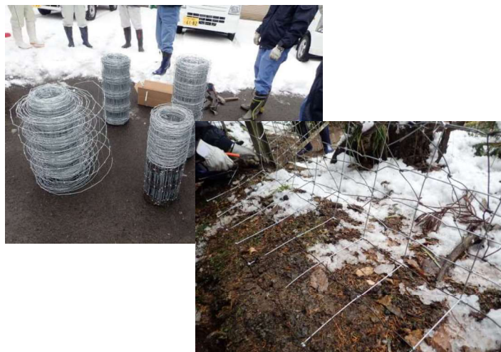
対策：柵の補強
