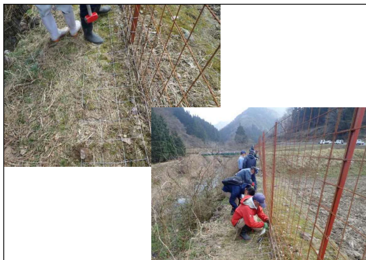
本プロジェクトで裾部分の改良
