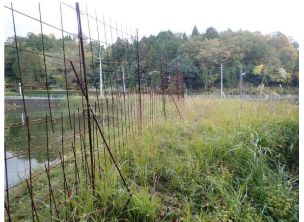
地域施WM柵(鉄柵)を設置
