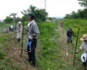
《電気柵設置の様子》
