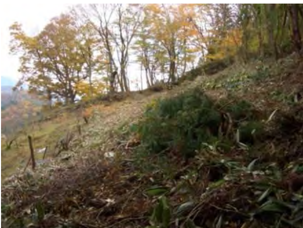
▲緩衝帯の整備
