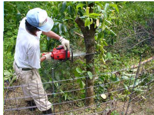
▲防護柵周辺の環境整備
