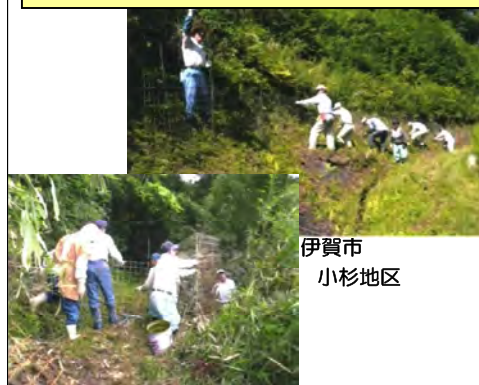
伊賀市 小杉地区 出会い作業で集落全体 に防止柵を設置
