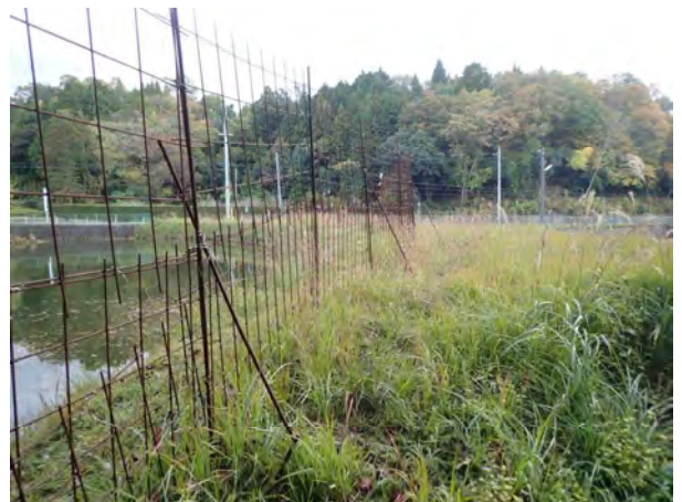
地域施WM柵(鉄柵)を設置
