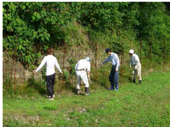
設置したWM柵は地域で点検
