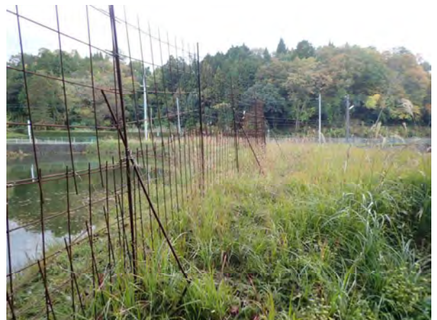
地域施WM柵(鉄柵)を設置
