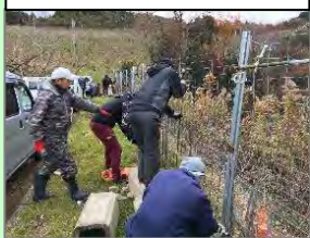
柵の集落一斉点検の様子
