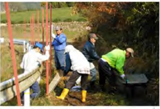
共同作業で柵を設置
