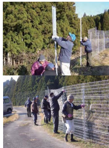
全長約4kmを住民自らの 作業で設置
