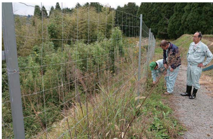
写真12 2011年から耕作放棄地を解消するための基盤整備がすすめられ、防護柵もあわせて整備中
