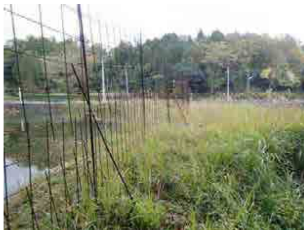
地域施WM柵(鉄柵)を設置
