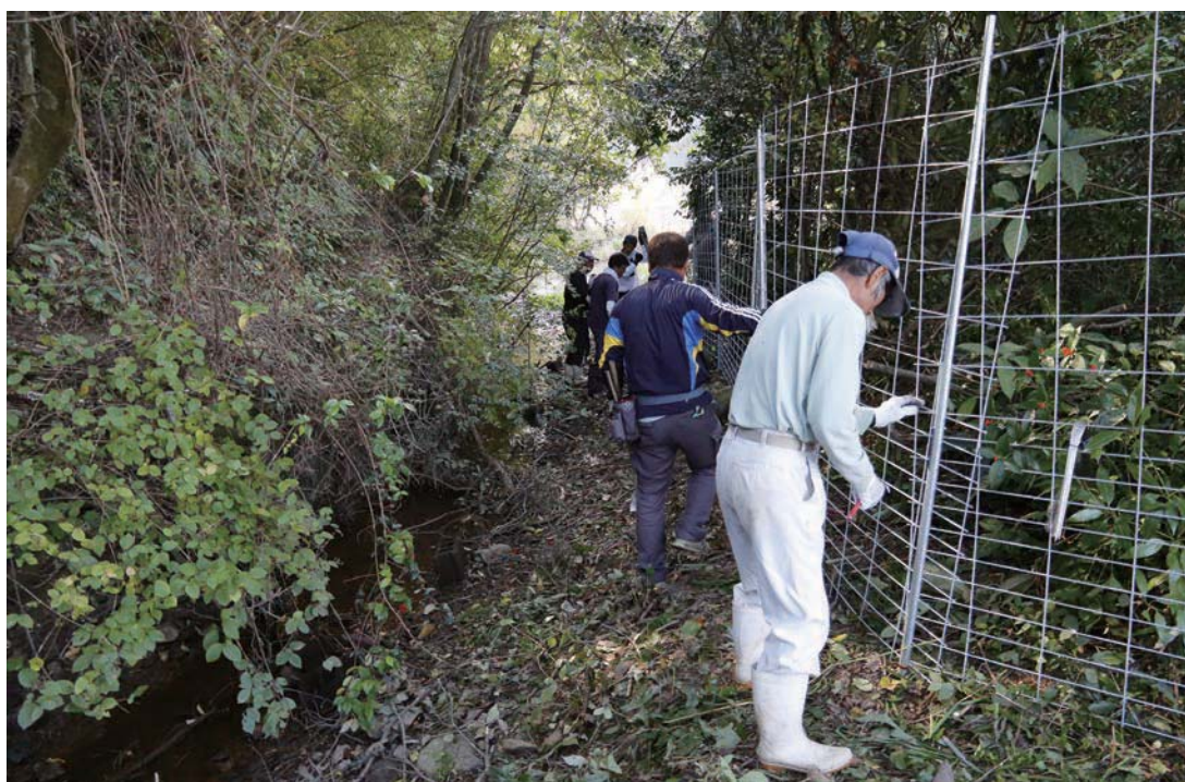
写真8 隣の山路集落と協力しながら防護柵の設置を進める坂本集落の住民
