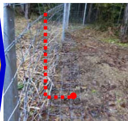
潜り込み対策 (山側にスカート設置)
