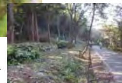
緩衝帯の設置
