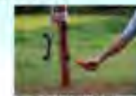
侵入防止柵の設置
