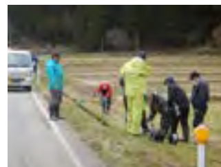
電気柵の設置
