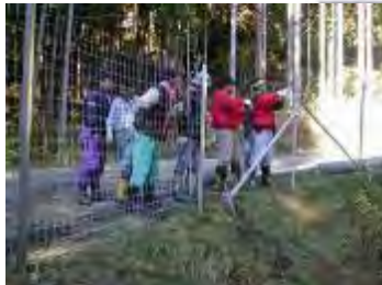
侵入防止柵の設置
