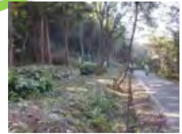
緩衝帯の整備
