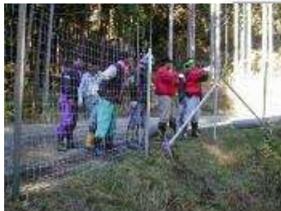
侵入防止柵の設置
