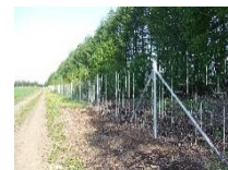
強固な侵入防止柵
