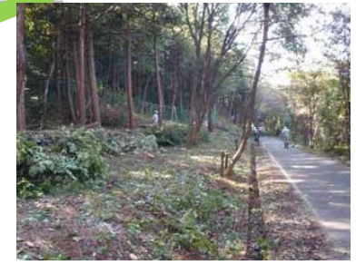
緩衝帯の整備
