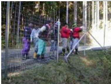
侵入防止柵の設置
