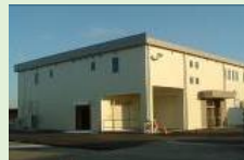
集出荷貯蔵施設
