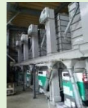
穀類乾燥調製施設 (ライスセンター)
