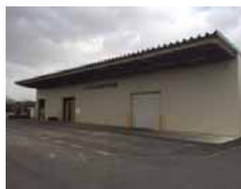
集出荷予冷施設
