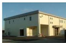
集出荷貯蔵施設
