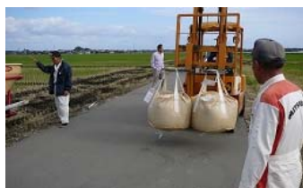
フレコン資材の散布作業
