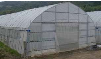
パイプハウス
