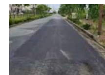
舗装した道路
