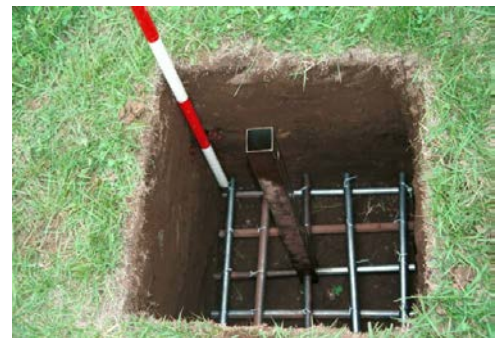
パイプによる基礎部の補強*
