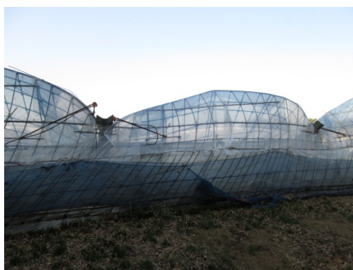
積雪と強風により横倒しに倒壊した事例
