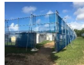
防風ネットの設置
