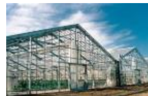
(複合環境制御装置を備えた温室)
