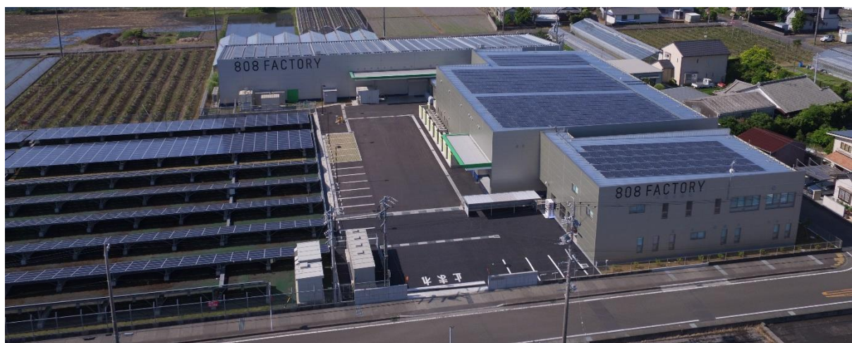
写真：工場屋上および敷地内に設置された太陽光パネル
