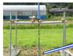
杭の引抜き強度試験機
