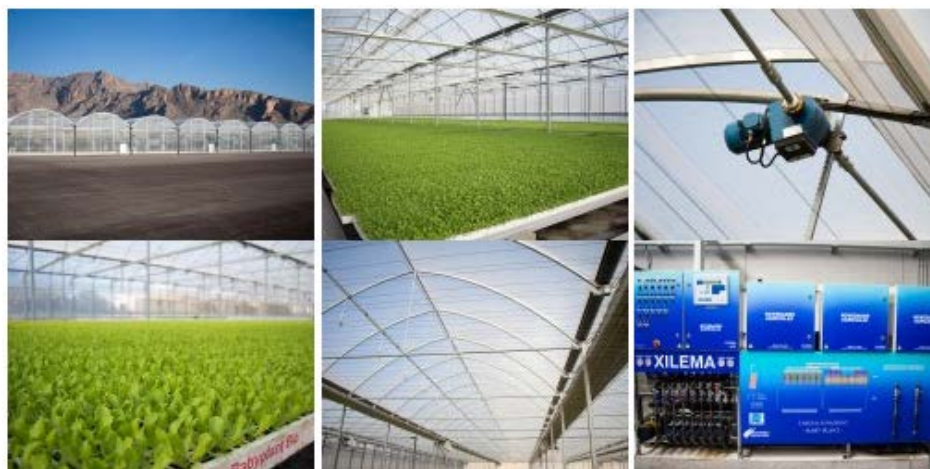
事例3: マルチトンネル式農業用ハウス
