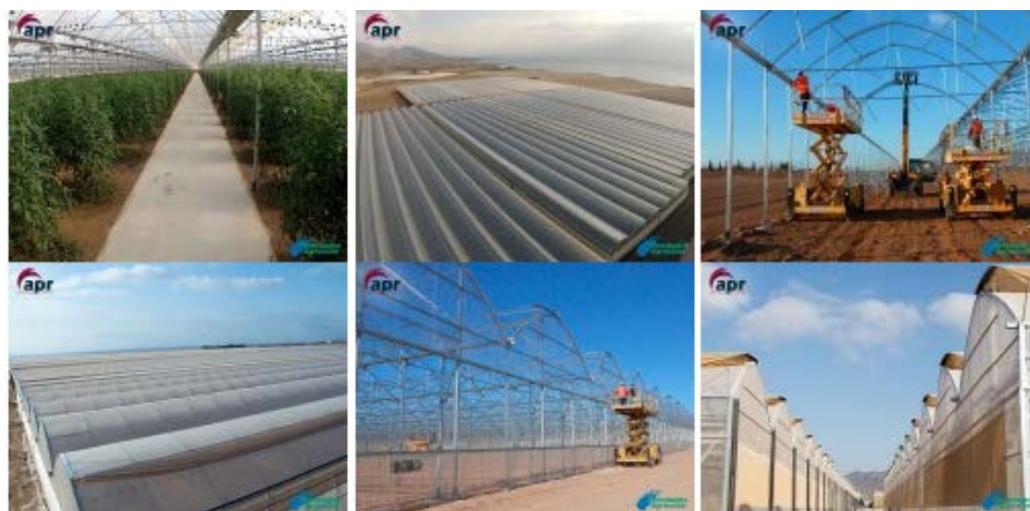
事例1: マルチトンネル式農業用ハウス
