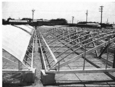
図3 地上で組み立てて並べられた屋根ユニット
