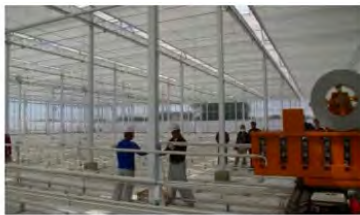
ガターの成形機によるハウス内でのフォーミング状況
