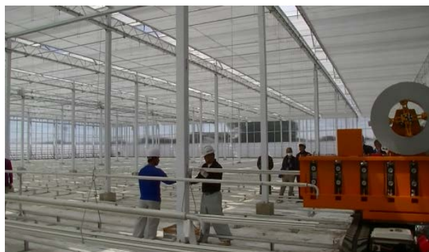
ガターの成形機によるハウス内でのフォーミング状況
