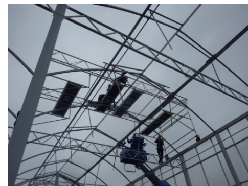
ルーフサービスカーを使用し てのフィルム展張作業
