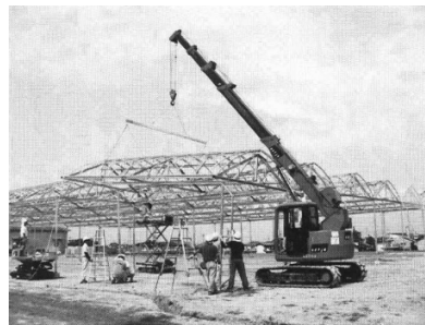
図4 屋根ユニットのクレーン吊り上げ・組み立て
