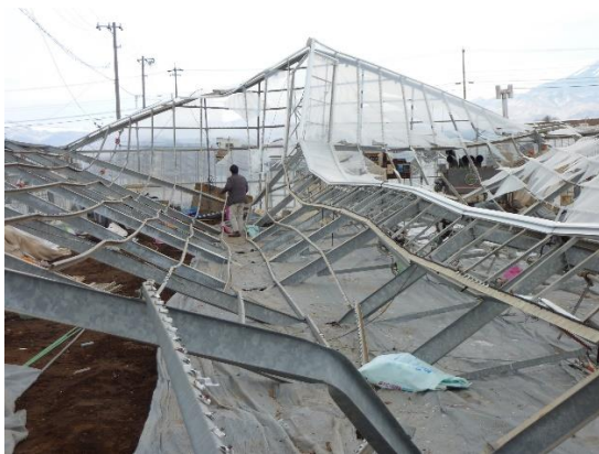
台風や大雪で被害を受けたハウスの被害事例
