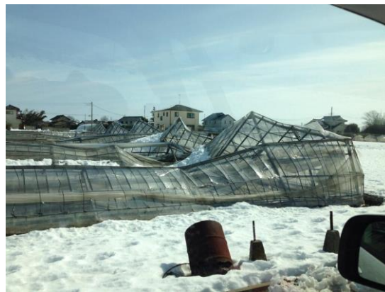
台風や大雪で被害を受けたハウスの被害事例
