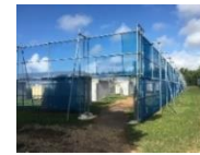
防風ネットの設置
