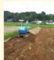
土層改良（客土）
