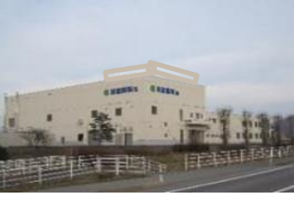
米粉製粉工場
