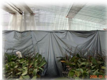
温室北面へ断熱資材を固定張り
