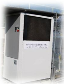
冷温水製造装置
