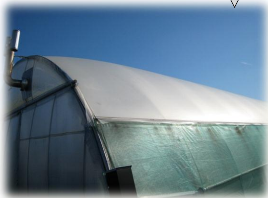
空気膜2重被覆（屋根部）
