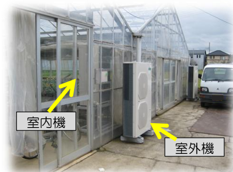
室内機と室外機の適切な設置例
